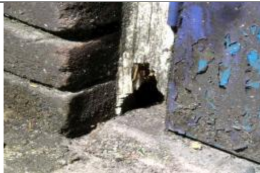
Rotten wooden door frame
